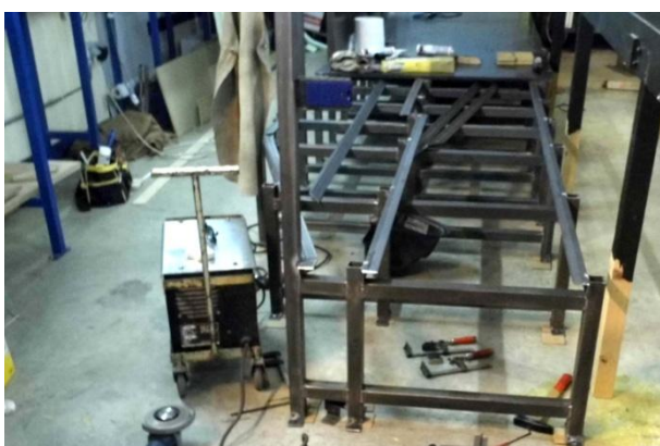
Fixation des supports et placement du plancher en bois marin recouverts de tôles en alu Larmé
