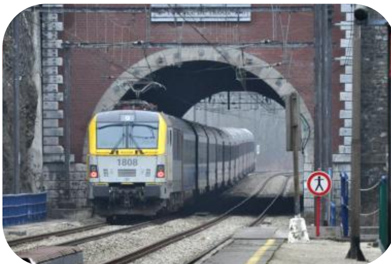
Tunnel de Trooz avec une 1808 en pousse.
